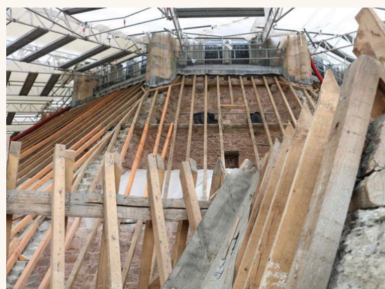
Le chantier de la Basilique p.9
