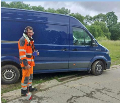
Des opérations de **recherche de fuites** ont également été réalisées sur l'ensemble du réseau communal grâce à un système de détection sonore, utilisé avec expertise par un agent communal.
