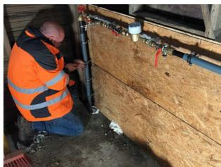
**PISCINE** - Suite à la détection de fuites, plusieurs éléments ont été remplacés : vannes, compteurs, disconnecteur et réducteur de pression.
