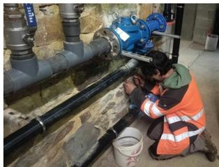
**PARC A GIBIERS** - Des conduites ont été remplacées, accompagnées de la pose d'une nouvelle vanne, d'un compteur et d'un système de purge.
