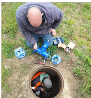
**ARVILLE** - Une vanne défectueuse a été remplacée dans une chambre de visite afin de sécuriser le réseau.
