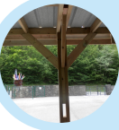
Ecole de Poix : construction d'un préau
